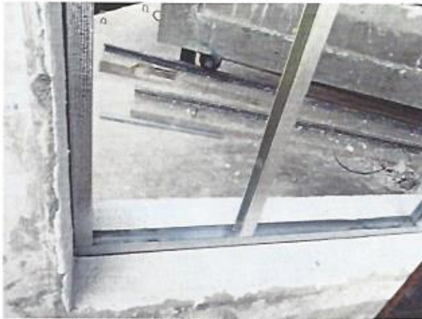
Foto 1 – Detalhe da montagem
