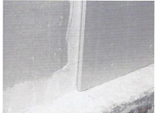
Foto 2 – Detalhe da montagem
